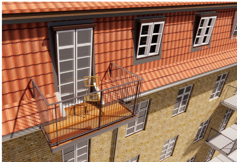
Her ses altandesignet på stål altan i mansard på en sydvendt facade mod gården.
