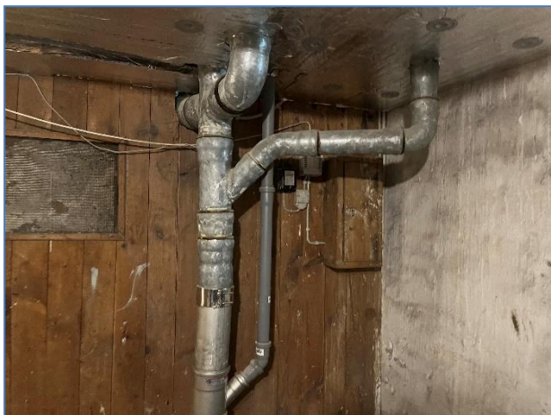
Foto 1: Faldstamme i kælder
