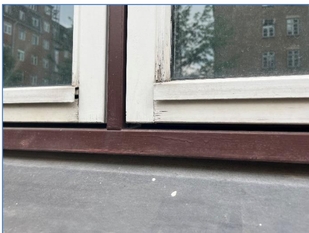
Foto 3: Vindue til bolig
