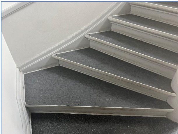
Foto 3: Trappeløb på hovedtrappe
