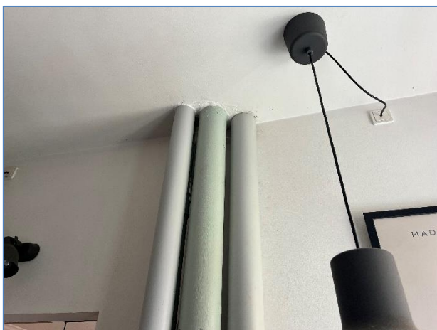
Foto 5: Rørføring i køkken
