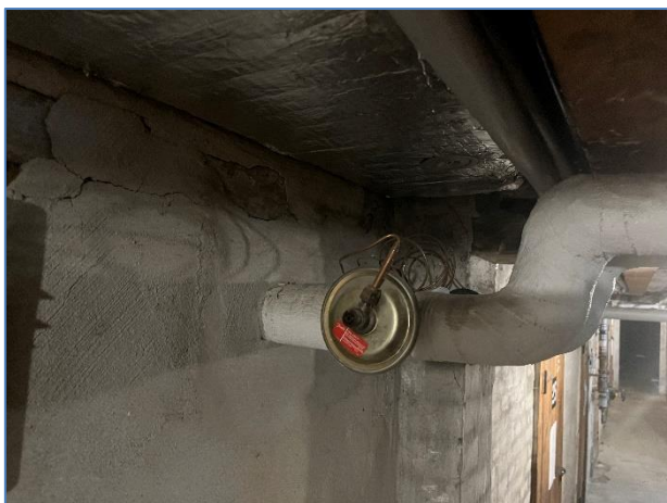
Foto 5: Rørføring i kælder
