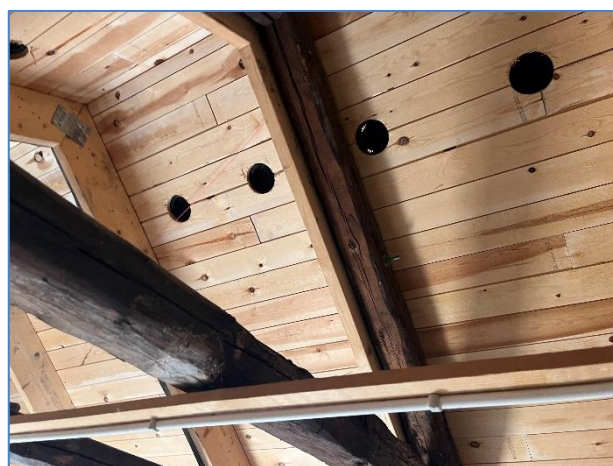
Foto 6: Undertag med ventilering
