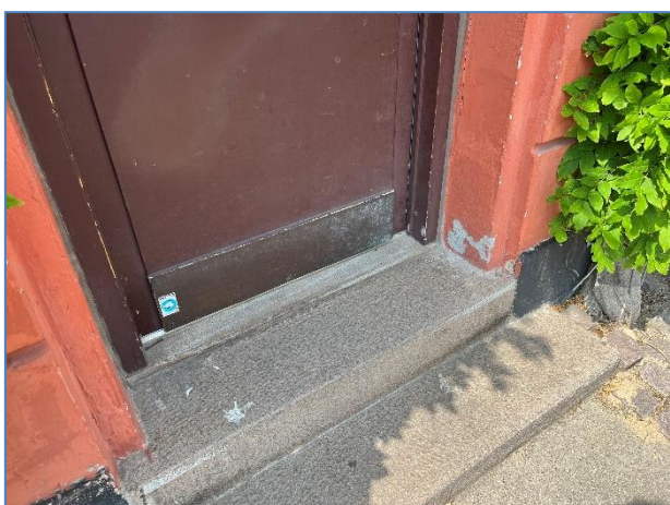
Foto 5: Forhøjning til indgangsdør
