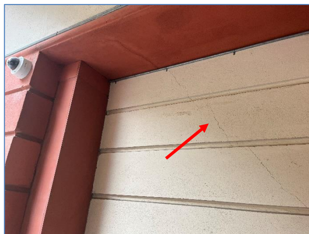
Foto 4: Væg i portgennemgang
