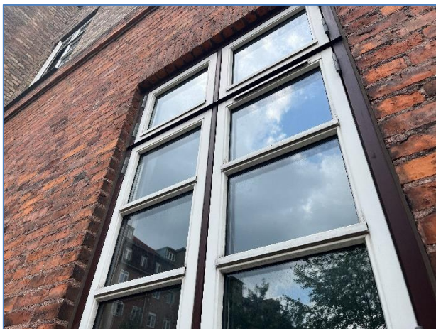
Foto 1: Vindue til bolig
