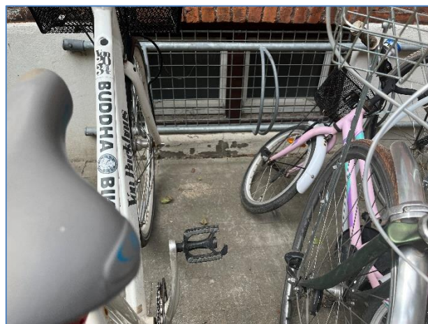
Foto 2: Forhøjning til kældervindue
