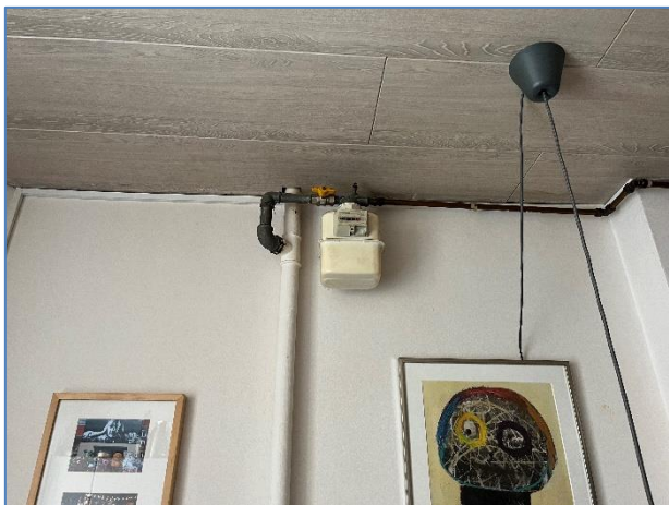
Foto 1: Gasmålerinstallation
